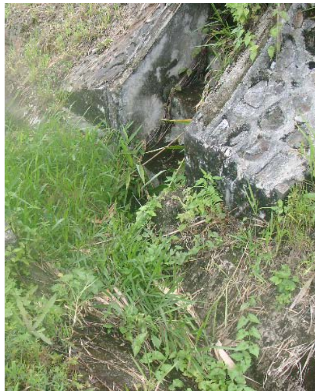
(d) Sump at toe of Slope
